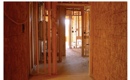
랭리시 아파트 중복지 공사 현장
