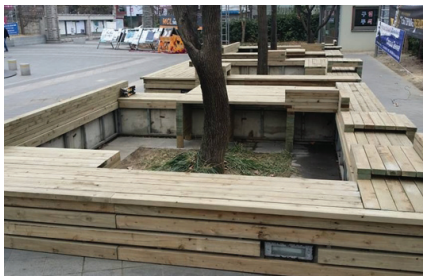
캠퍼스에 설치된 파빌리온
