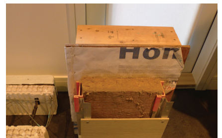
슈퍼 E 하우스의 레인 스크린 시스템 상세 모델
